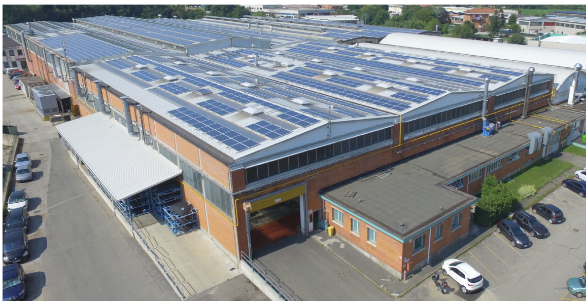
Stabilimento Cornaglia - Impianti fotovoltaici
